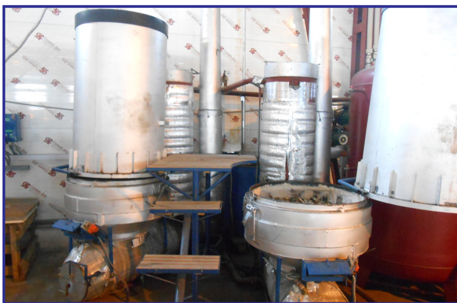
Рис.1. Твердопаливний газогенераторний котел СУП-ВТ 80М з водяним теплообмінником для спалювання біомаси, паливної тріски та відходів с.-г. виробництва. Виробник ТОВ «СІОНА».
